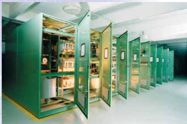
Bancos de capacitores en Media y Alta Tensión.
