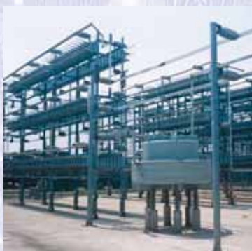
Bancos de capacitores en Media y Alta Tensión.
